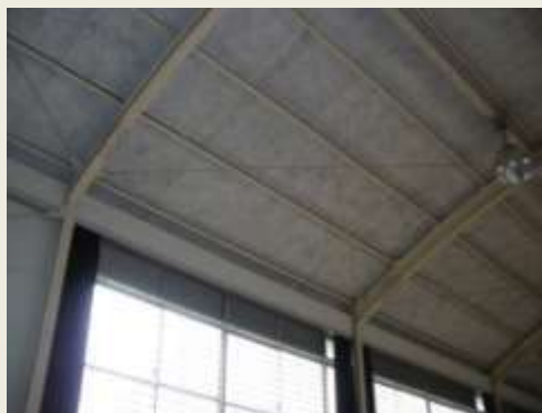
施工前→施工後
