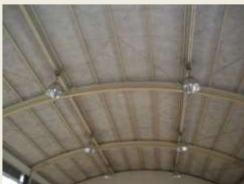
未施工／ガイナ施工箇所の比較：
