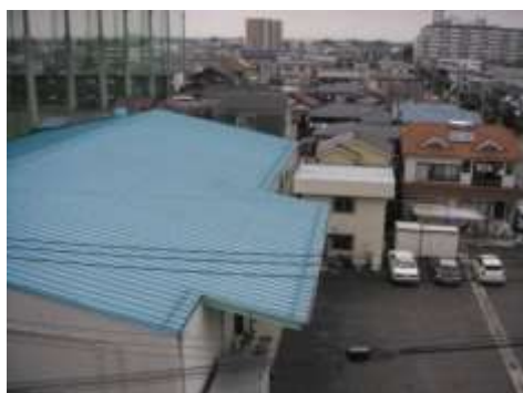
▲屋根塗装箇所
