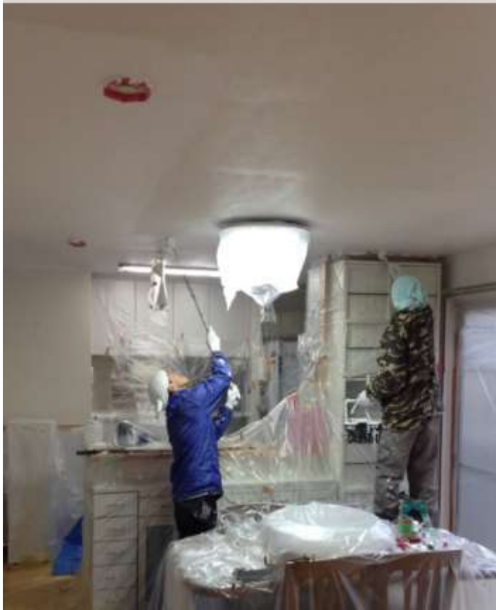
▼塗装施工風景
