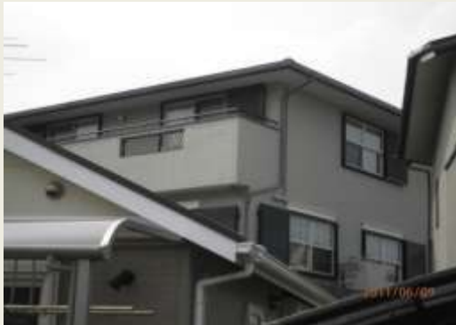
▲施工後 施工完了時期：6月初旬
